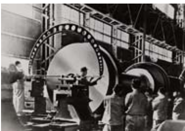
重工业中使用的超大型千分尺
